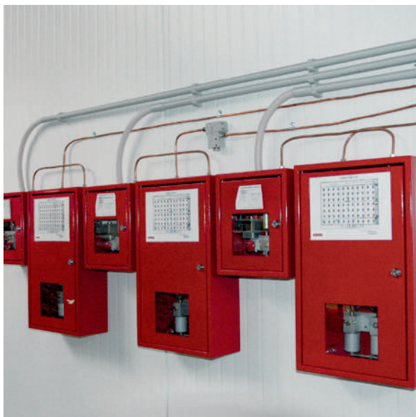
Rys. 1 Przykładowe zastosowanie pneumatycznych systemów sterowania oddymianiem
