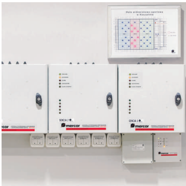
Rys. 2 Przykładowe zastosowanie elektrycznych systemów sterowania oddymianiem
